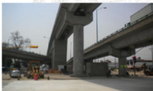
Puente vehicular James Watt (25 años); pago anual de 35 mdp
